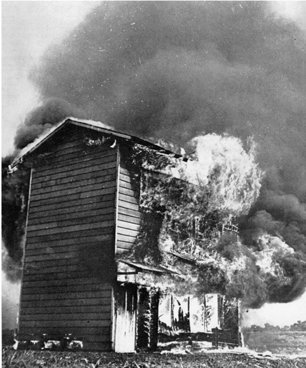
Fig. 7. Casa japonesa en llamas en EE. UU. Fuente: Standard Oil Development Company.
