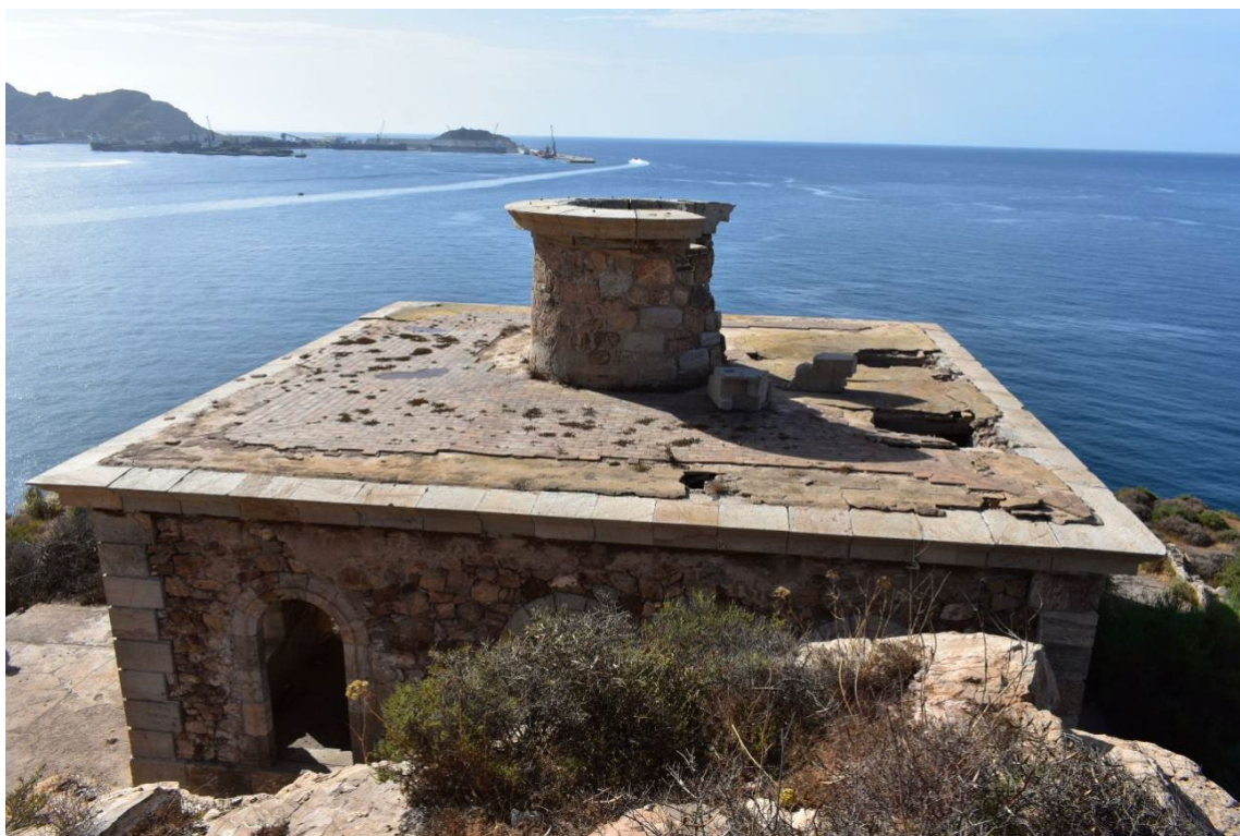
Imagen 5. Terraza superior, cuyas rasillas cubrían la totalidad de su superficie.
